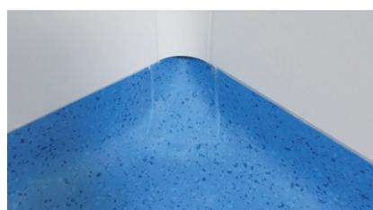
Revêtement de sol + cloison pharma (avec ou sans sections de plinthes)
